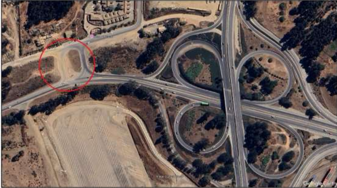
Conexión irregular no formal que se aprecia mediante Google Earth.
