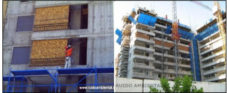
Figura. Imagen referencial de cierre de ventanas con paneles OSB
