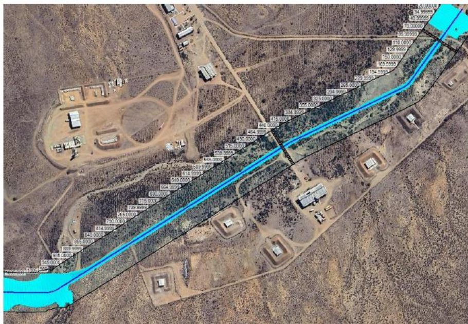
Fuente: Figura 3 del Anexo 16 de la Adenda Complementaria de la DIA. Vista general de la obra.
