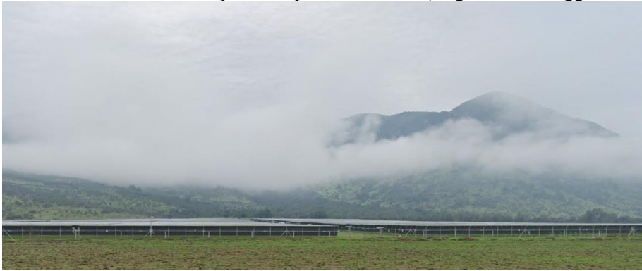
Figura AD- 2. Condición sitio típica con paneles solares (Región de O'Higgins, Palmilla)
