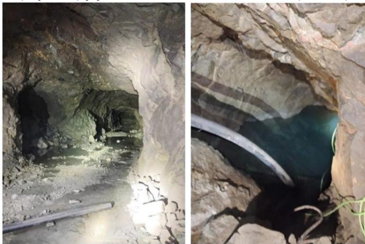
Figura 6.2.3: Afloramiento agua del minero cota 761 msnm. (izquierda) y pozo acumulador cota 746 msnm. (derecha).
