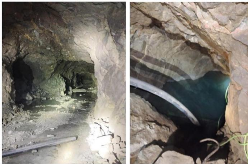
Figura 5.2.3: Afloramiento agua del minero cota 761 msnm (imagen izquierda) y pozo acumulador cota 746 msnm (imagen derecha).
