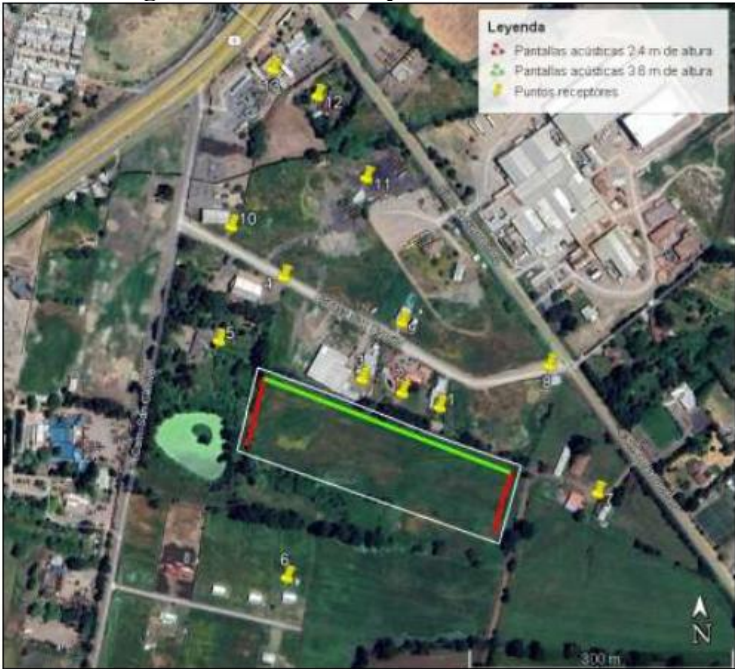
Figura. Ubicación de pantallas acústicas
