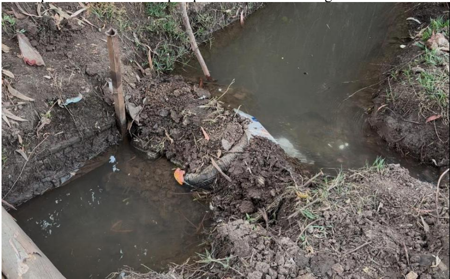
Fotografía 1 Dique o cierre de la acequia para el desvío de las aguas
