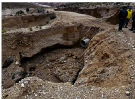
a) Obra tipo alcantarilla que se observa bajo el camino interior
