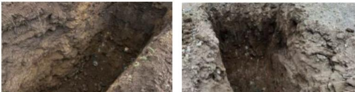
Fuente: Fotografía 2 Unidad Geológica Predominante – Sin evidencias de afloramiento de aguas – Anexo Adenda Ciudadana – Adenda Complementaria
