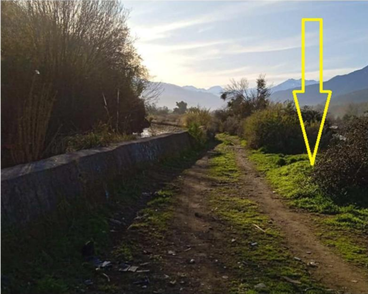
Fuente: Fotografía 1 Ejemplo sector donde se instalaría poste de hormigón a no menos de 5,0 m de distancia del borde del canal. – Anexo Adenda Ciudadana – Adenda Complementaria
