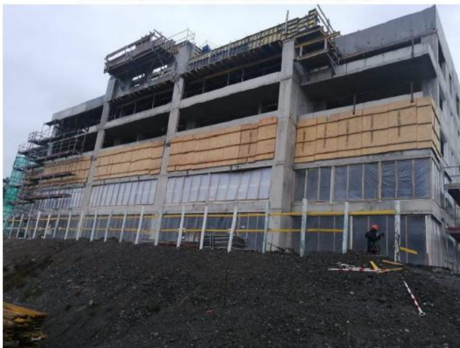
Figura 29. Ejemplo de implementación de cierre de vanos.
