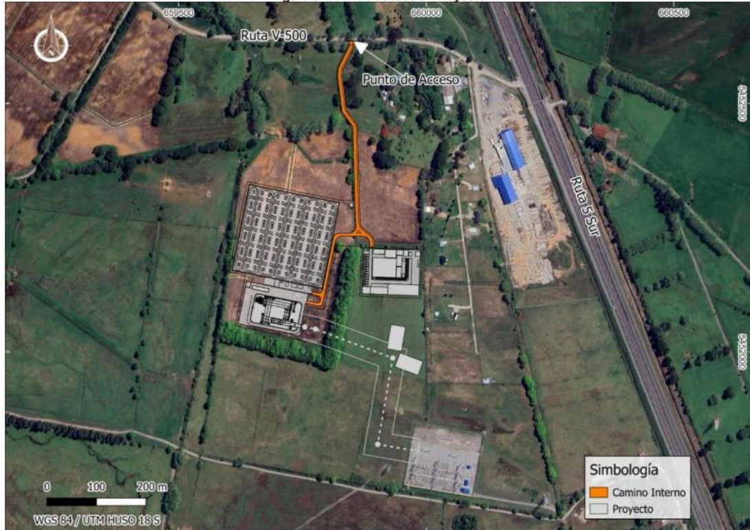
Figura 6. Ruta de acceso al Proyecto
