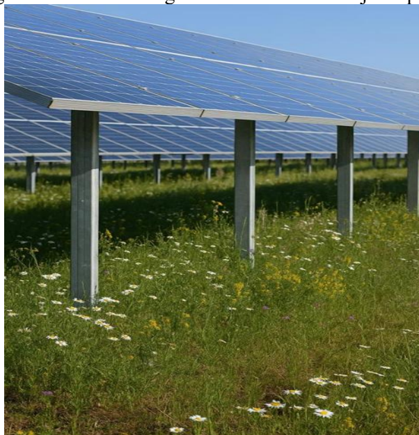
Figura: Imagen referencial de vegetación creciendo debajo de paneles solares
