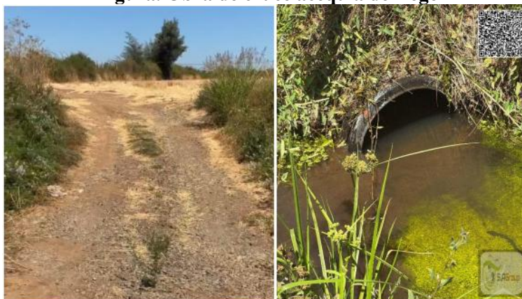
Figura. Obra de cruce acequia de riego
