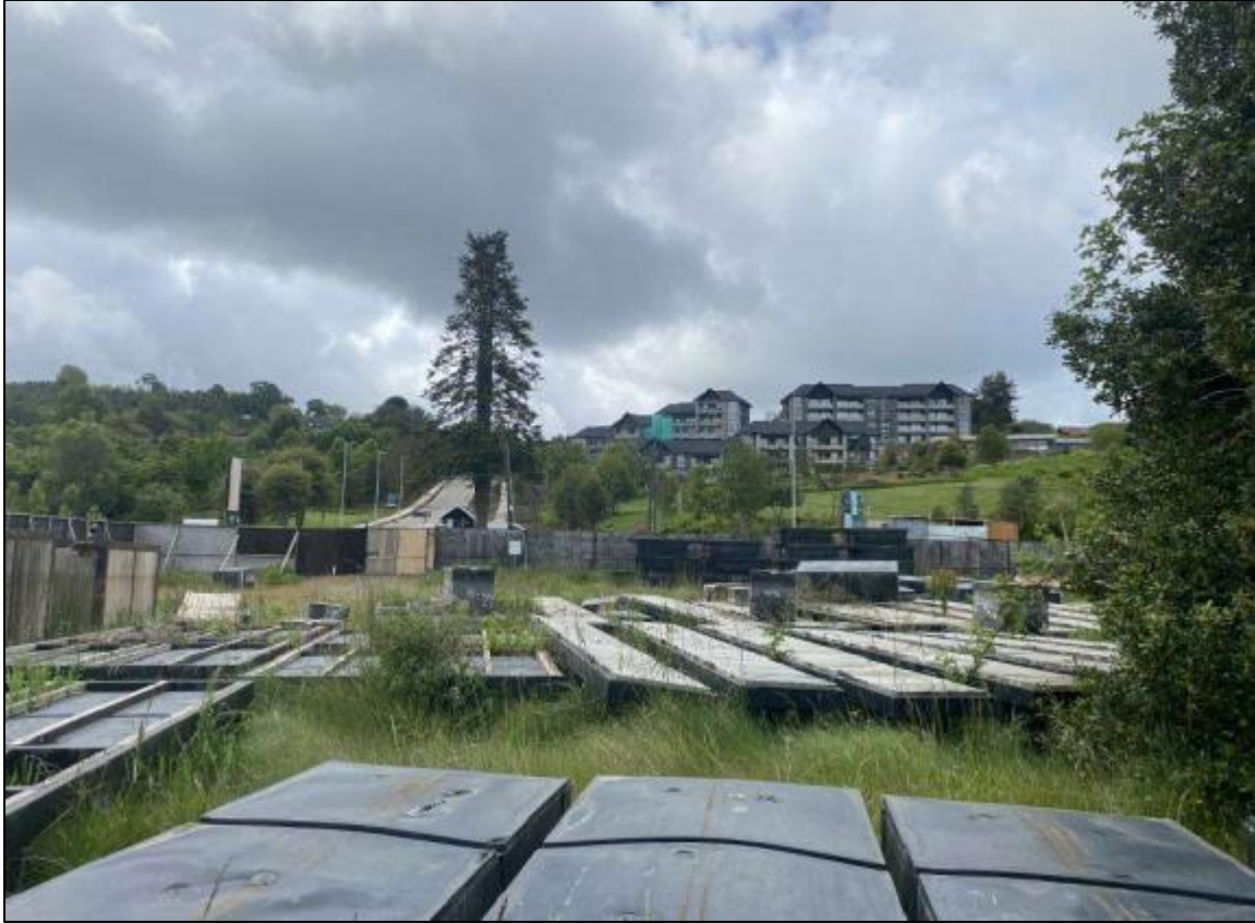
Figura 12.51 Sector de acopio de acumulación de estructuras de muelle
