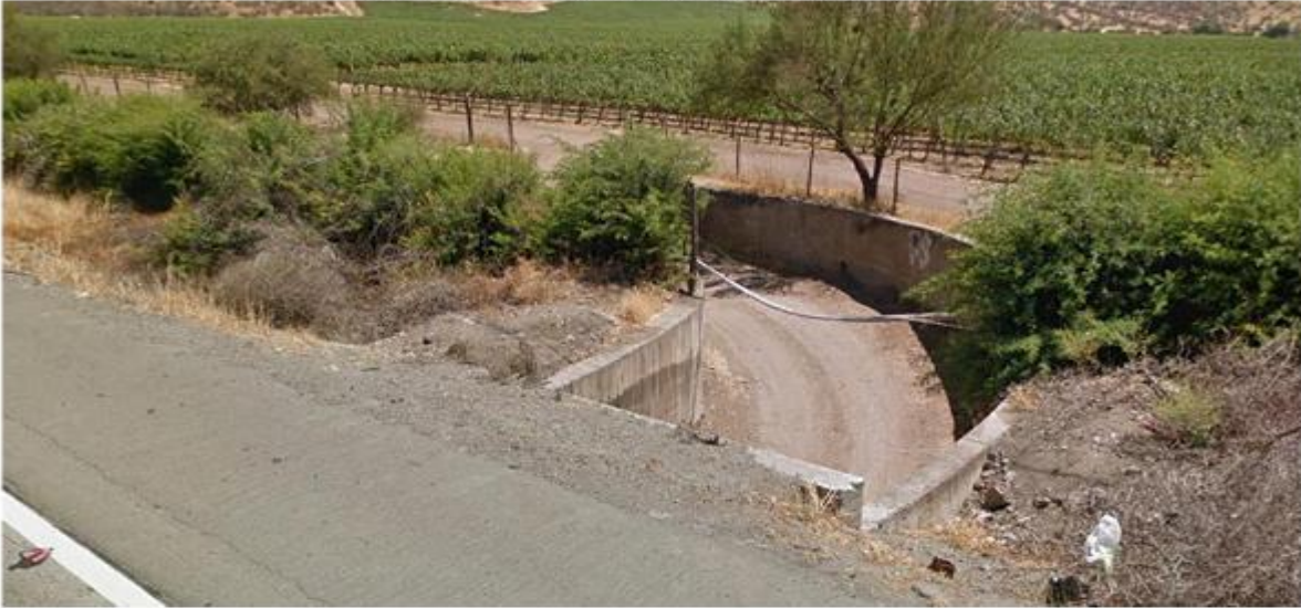
Fotografía 2. Encauzamiento aguas arriba de la obra de arte
