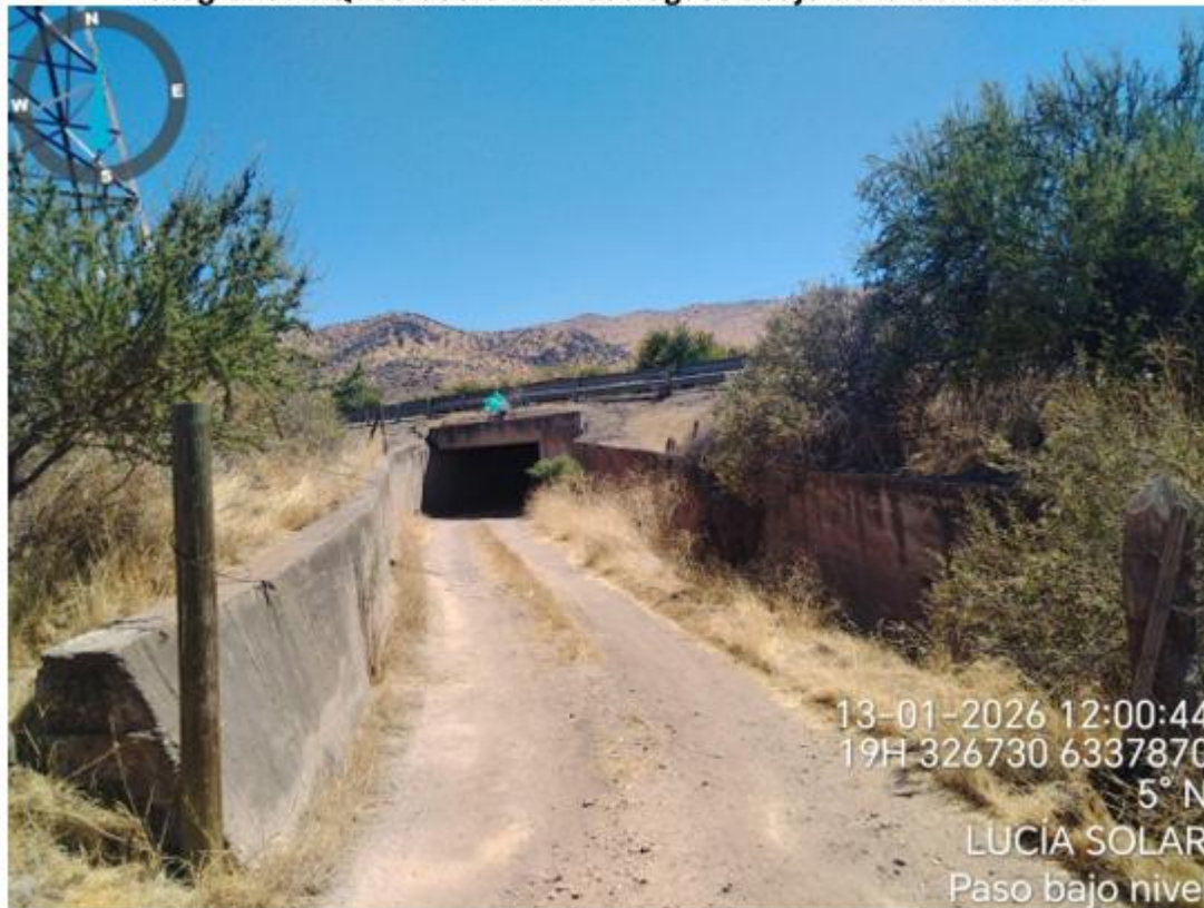
Fotografía 1. Quebrada encauzada aguas abajo de la obra de arte
