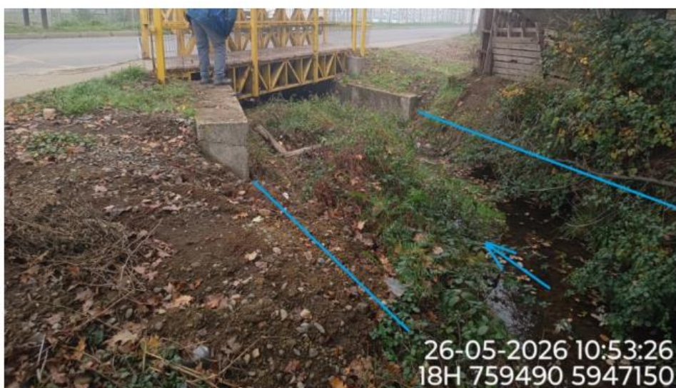
Foto 3: Puente en Avenida Paul Harris de 5 m de ancho por 1 profundidad
