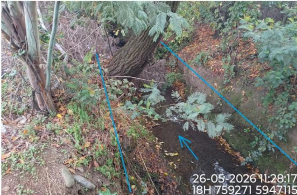
Foto 4: El canal presenta un tramo sobre la propiedad de COPEVAL Chillán, en el lugar existe una bodega donde se acopian productos químicos.
