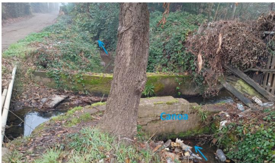
Foto 2: Canoa sobre el canal Lantaño. En este punto la sección de escurrimiento del canal Lantaño bajo la canoa es ínfimo.
