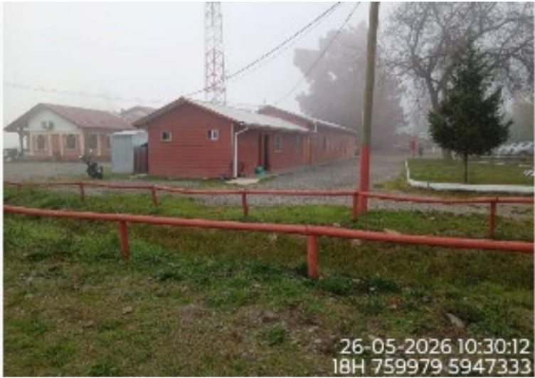
Foto 1: Base de CONAF, se inunda con frecuencia por desborde del canal Lantaño. En este terreno existe un helipuerto y oficinas que son inaccesibles con los desbordes del canal Lantaño.
