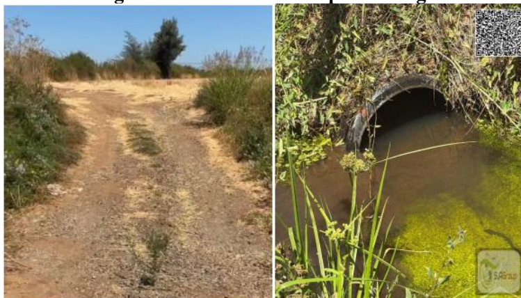
Figura. Obra de cruce acequia de riego
