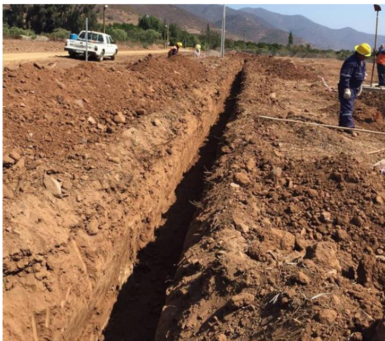
Fuente: Figura 1-26. Construcción Zanja de Cableado soterrado, de la DIA.
