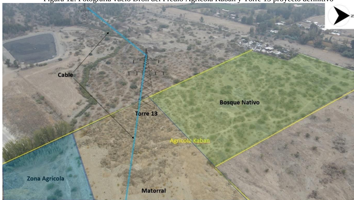
Figura 12: Fotografía vuelo Dron del Predio Agrícola Kaban y Torre 13 proyecto definitivo
