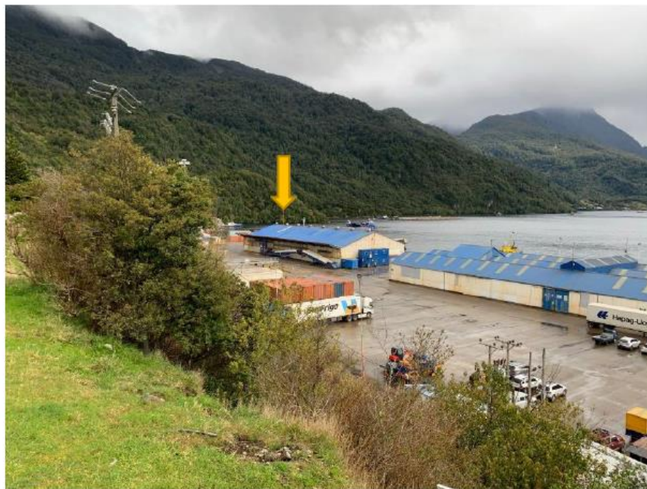
Figura 12. Figura 2 del Anexo PAC, correspondiente a “Vista desde el mirador hacia el sector de la descarga de aguas servidas”.
