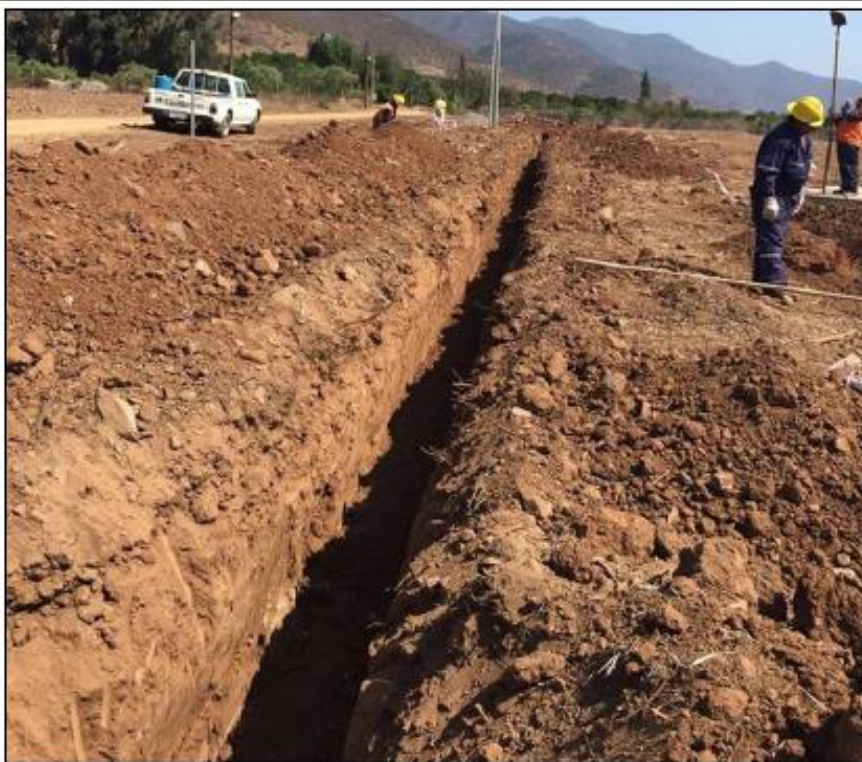
Figura 1-32. Disposición Temporal de Material Excavado.
