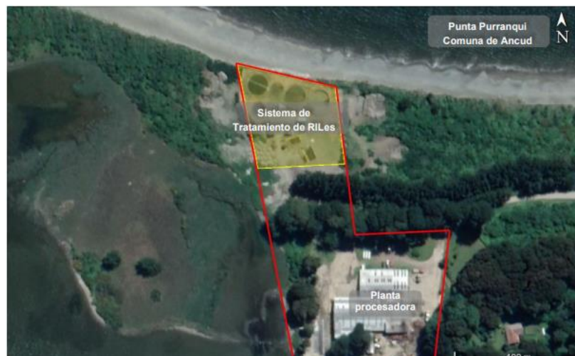
Fig. 2: Emplazamiento sistema de tratamiento
