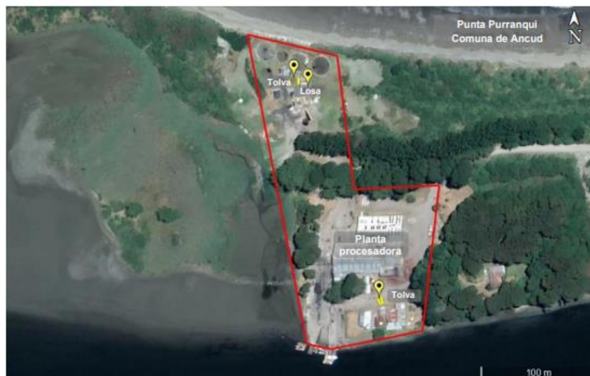
Fig. 1: Almacenamiento de residuos no peligrosos.
