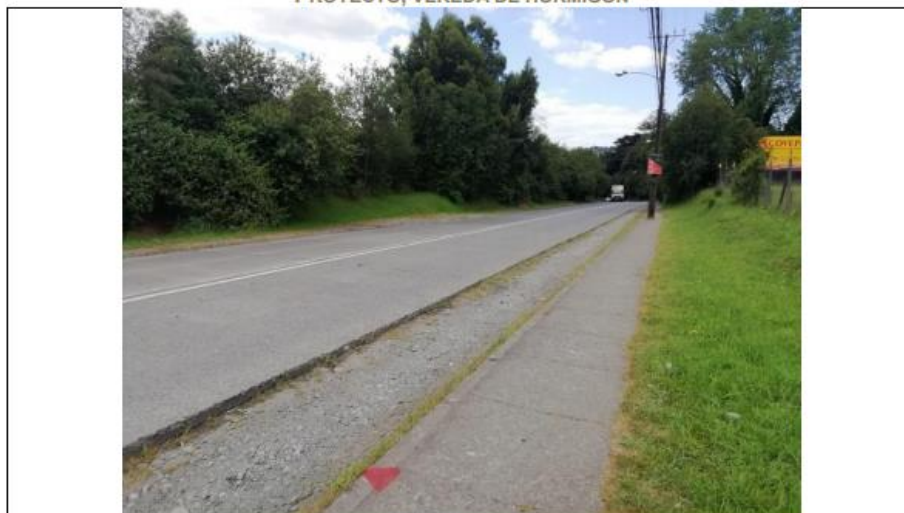
FOTOGRAFÍA 9. AV. PADRE JOSÉ NEUDORFER, HACIA EL NORTE DESDE EL ÁREA DEL PROYECTO, VEREDA DE HORMIGÓN
