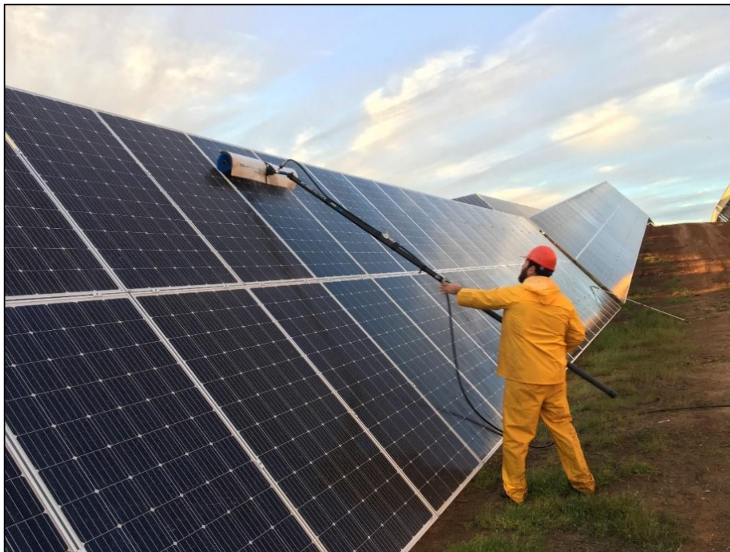
Referencia de limpieza manual de paneles FV
