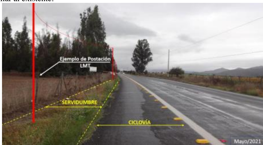
Fuente: Figura 12 Vista Referencial Postación y su Relación con la Ciclovía, Anexo 02, Adenda Ciudadana
