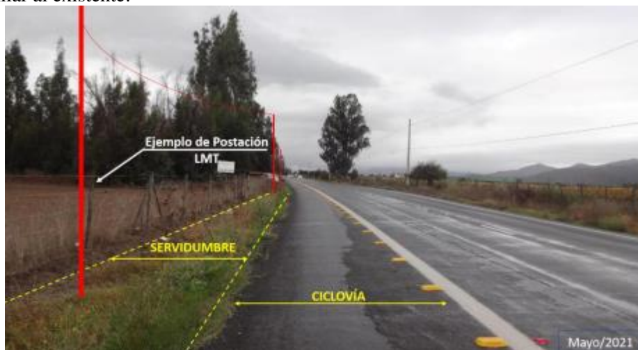
Fuente: Figura 12 Vista Referencial Postación y su Relación con la Ciclovía, Anexo 02, Adenda Ciudadana
