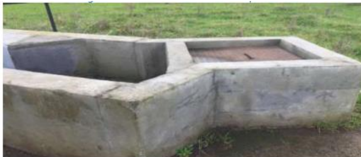
Figura 18. Cámara de muestreo
