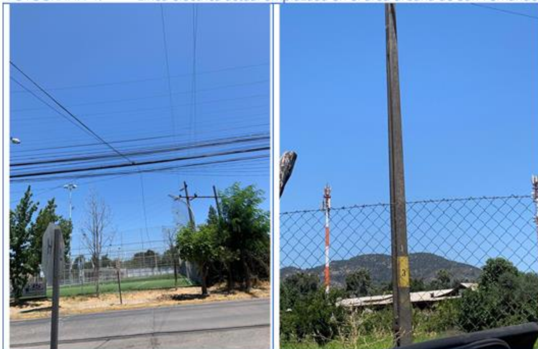
FOTOGRAFÍA-1: Línea eléctrica actual emplazada en el área urbana de San Fernando
