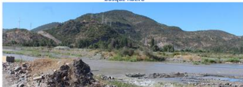
FOTOGRAFÍA-2: Estructuras de transmisión eléctrica en zona con presencia de bosque nativo
